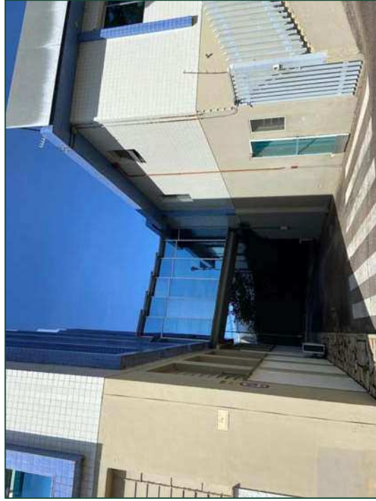
04. Área Externa Prédio Administrativo (4)
