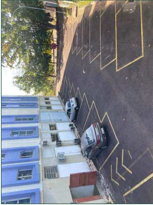
04. Área Externa Prédio Administrativo (2)
