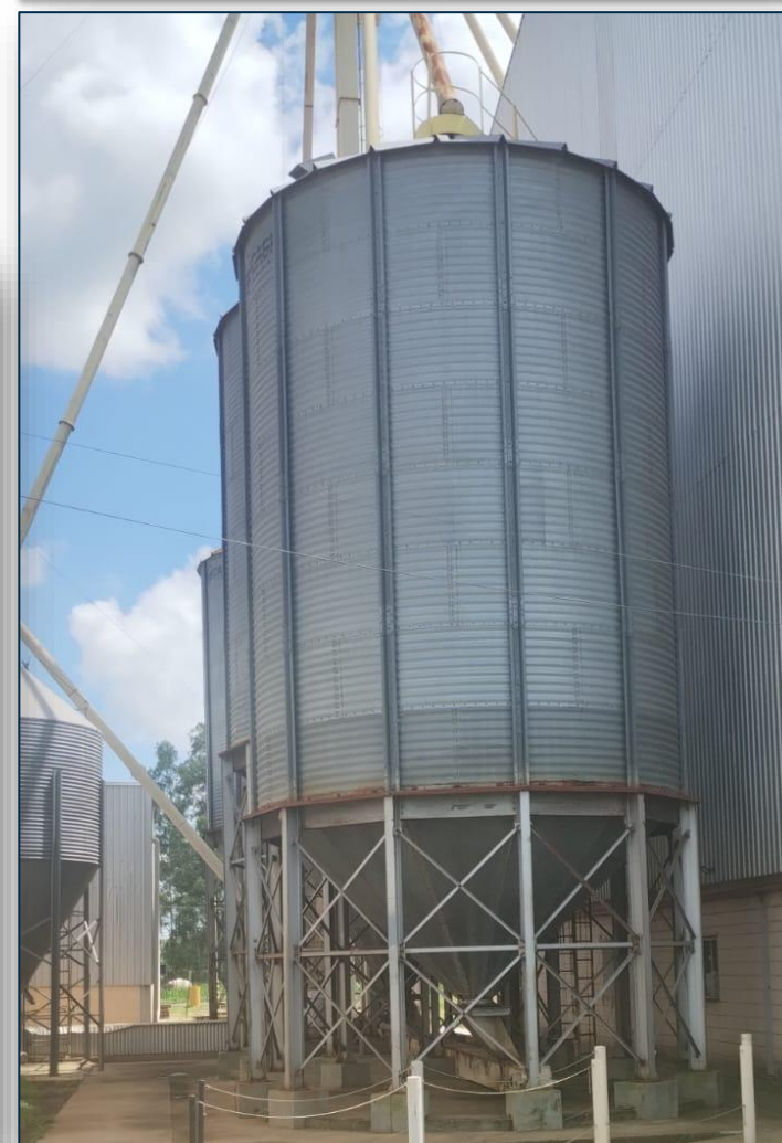
Silos de armazenamento
